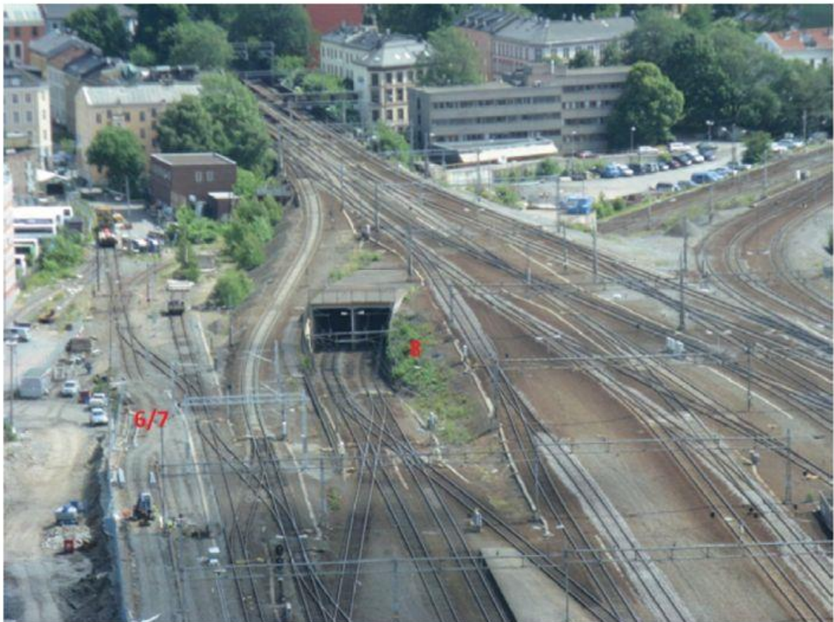
Figur 34-4 Oversiktsbilde sporområdet ved Akse 6, 7 og 8
