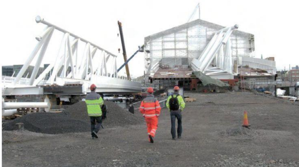
Figur 34-14 Sveising av del 1 og 2, mens del 3 venter
