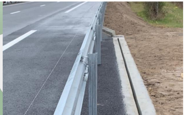
Fig 10. Ouvrage assainissement longitudinal : Caniveau à fente
