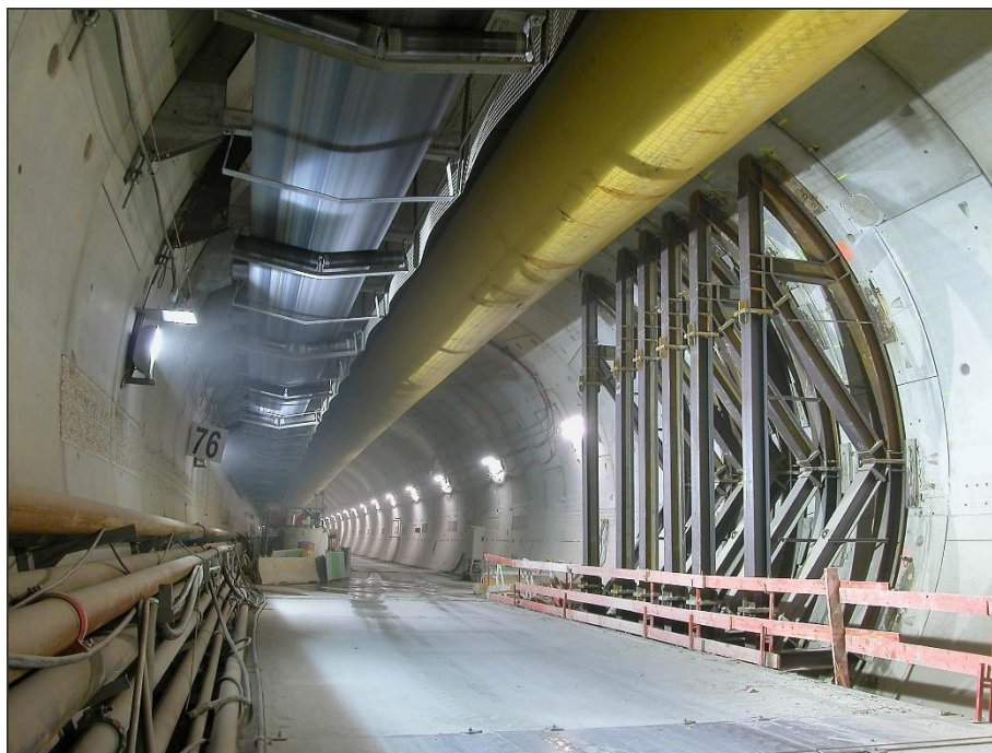
Fig 1. Vue générale des servitudes nécessaires à l'avancement du creusement
