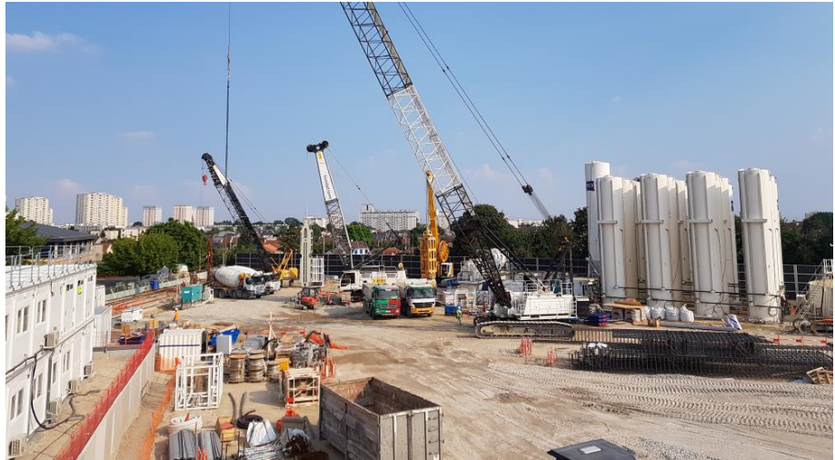
Fig 3. Vue générale d'une installation de chantier -Silo-Base vie-circulation des engins
