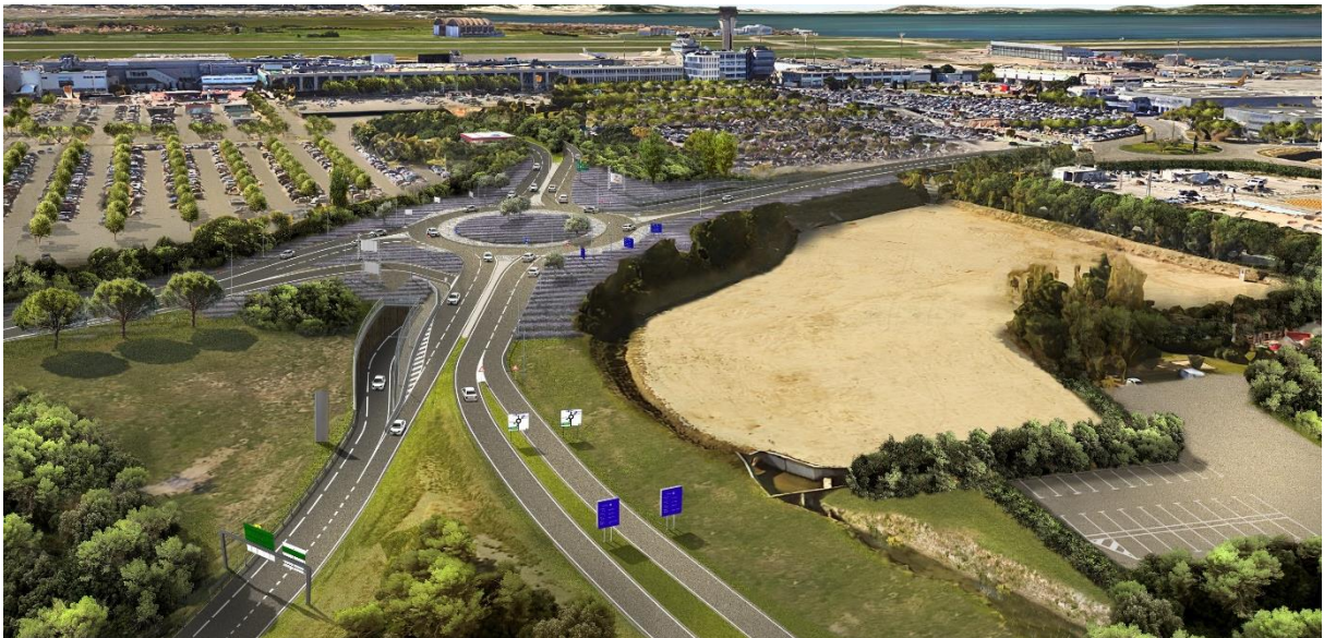
Fig.17 : Rond-Point des Lavandes donnant accès à l'Aéroport de Marseille Provence (AMP)
