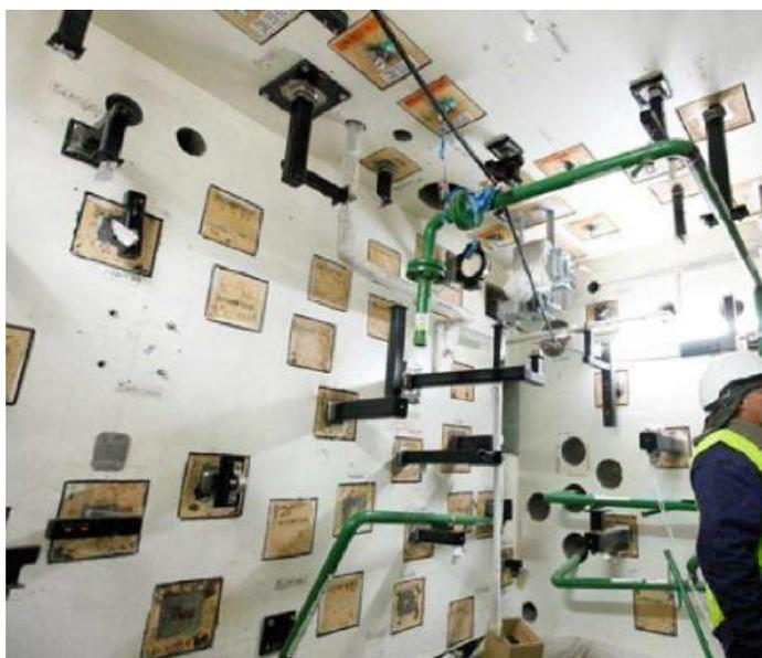
Fig.58 : Platines (coulées dans le béton) support du process nucléaire
