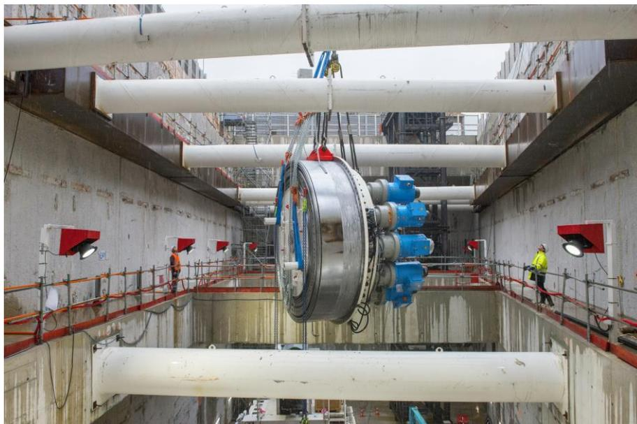
Fig.61 : Descente d'éléments de tunnelier dans le puits Glarner de la Ligne 14 du GPE
