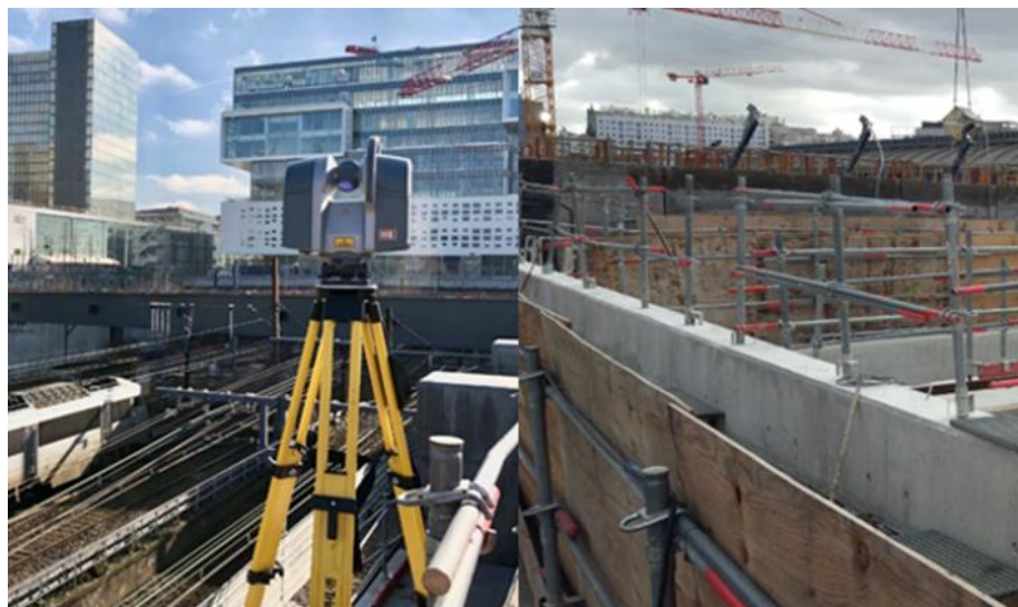
Fig 23. Prises de vue sur le terrain et positionnement des cibles topo. Source : Eiffage.
