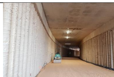
Intérieur du passage inférieur
