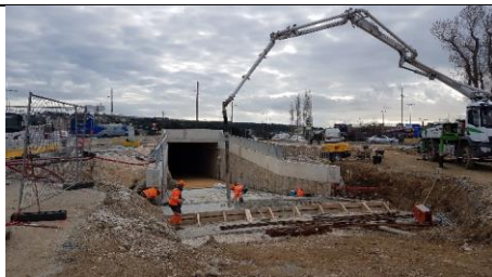
Trémie d'entrée depuis les terminaux
